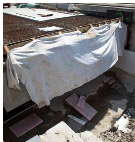
Mostní opěra po demolici závěrné zídky a úložného prahu
