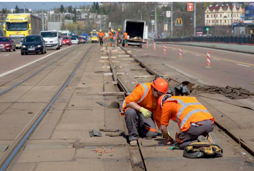
Demontáž stávající tramvajové trati.
