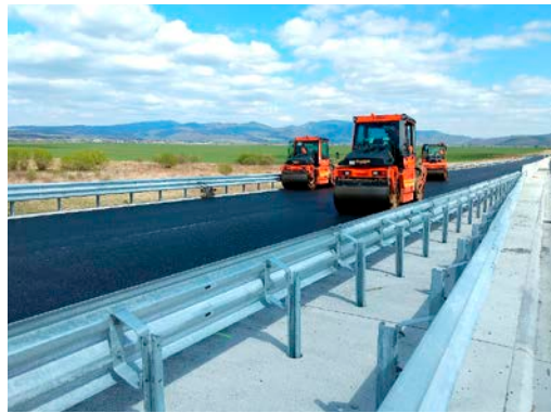
Naša mechanizácia pri práci na obrusnej vrstve na R2 Zvolen-východ–Pstruša, úsek bol odovzdaný v minulom roku
