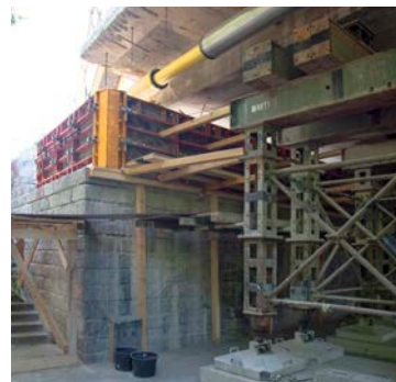
Pohled na provizorní skruží PIŽMO (podpěření nosné konstrukce)
