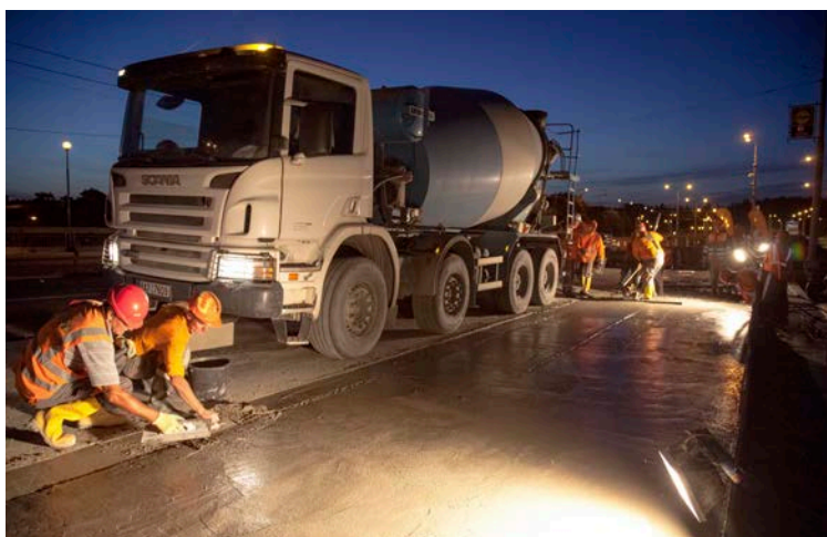
Betonáž nové vyrovnávací desky.
