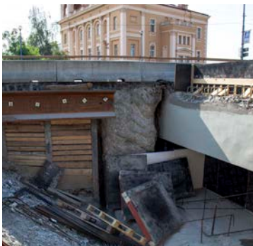
Výkop přechodové oblasti se záporovým pažením
