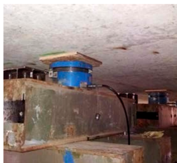
Hydraulické lisy a provizorní ocelové stolice pro zvedání nosné konstrukce.
