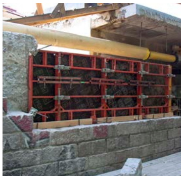
Bednění nového úložného prahu a pohled na novou přeložku plynovodu
